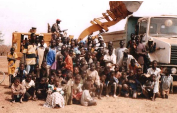
Straßenbau von Ouélé nach Dio
